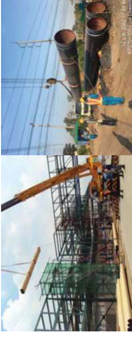
วัสดุที่ต้องผูกติด Tag line เชือกดึง มีขนาดยาว 5 เมตรขึ้นไป และดูตามความเหมาะสมของเงินงานที่จะยกขึ้น The material that is lifted must be named Tag line 5 meters in length and look appropriate for the work piece to be lifted with
